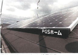
同社オリジナルパネルの設置風景
