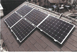
同社が施工した住宅
